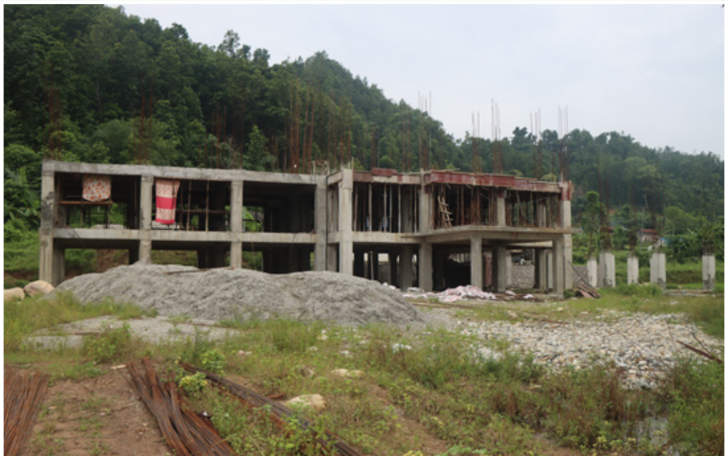
राक्सिराङ्ग गाउँ कार्यपालिकाको कार्यालयको निर्माणाधीन भवन
