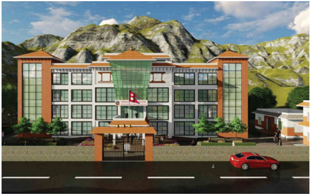
राक्सिराङ्ग गाउँ कार्यपालिकाको कार्यालयको निर्माणाधीन प्रशासकीय भवनको नमूना फोटो
